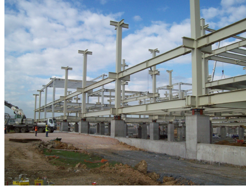
Şekil 1.3 : Sabiha Gökçen Uluslararası Havalimanına ait sismik izolatör kolon giriş birleşimi ve çelik üst yapı [1].
