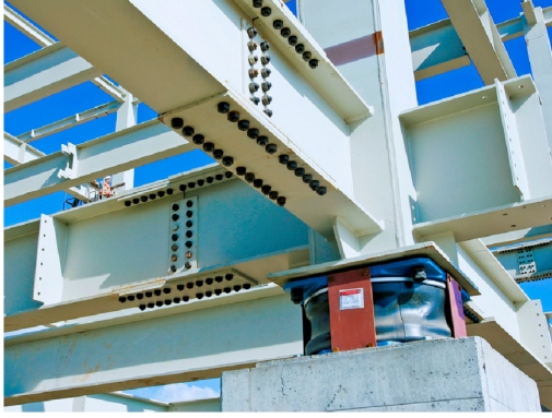
Şekil 1.3 : Sabiha Gökçen Uluslararası Havalimanına ait sismik izolatör kolon giriş birleşimi ve çelik üst yapı [1].
